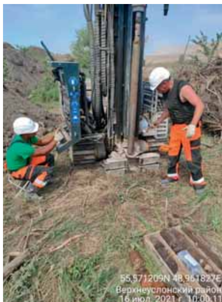
Рис. 10. Выполнение ООО «Автодор-Инжиниринг» контрольного бурения. М-12 Москва – Казань, VIII этап, Республика Татарстан, 2021 год
