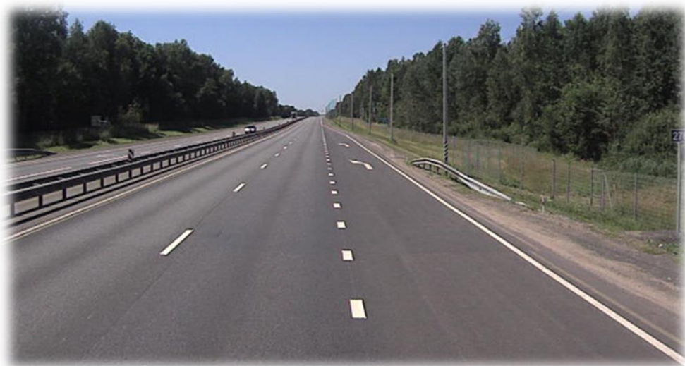
Прямое направление км 276+000 БНД 70/100 (PG 64-22) ЗАО «МПК» КРЗ»
