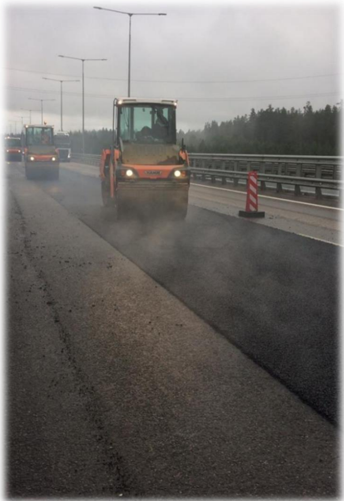
Устройство верхнего слоя покрытия на участке км 318 – км 319. Август 2021 года.
