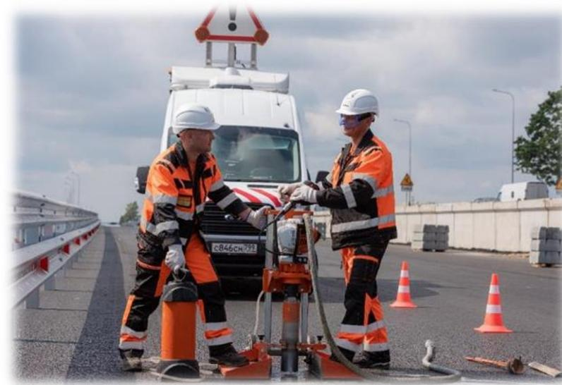
ООО «Автодор-Инжиниринг» планирует внедрение оценки качества производимых работ по устройству конструктивных слоев автомобильных дорог с применением радиоизотопных плотномеров
