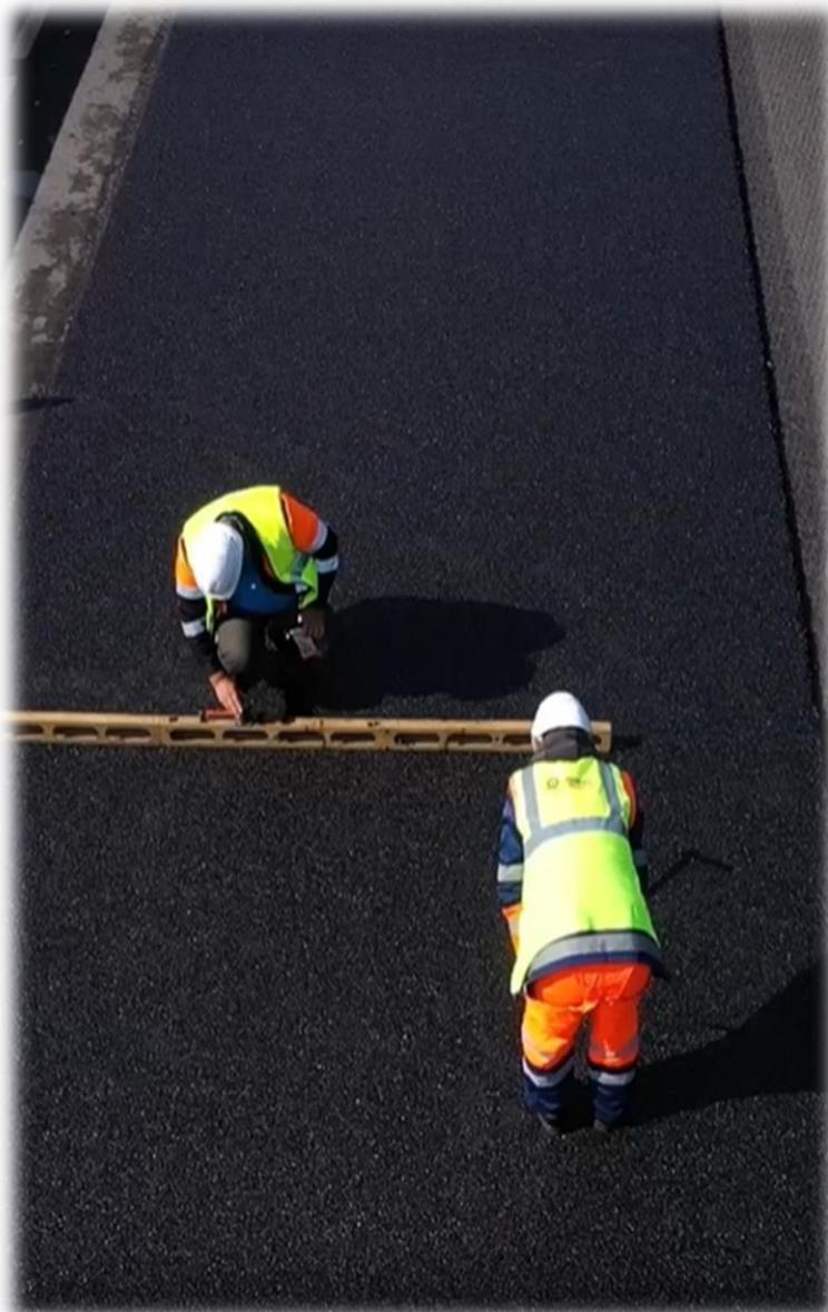
Входной, операционный и приемочный контроль качества, включая испытания материалов, входящих в АБС
