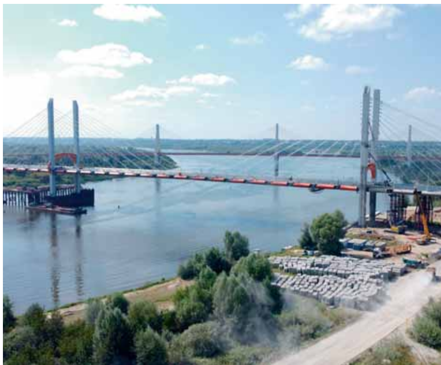
Рис. 3. Строительство вантового моста через реку Оку в районе города Муром
