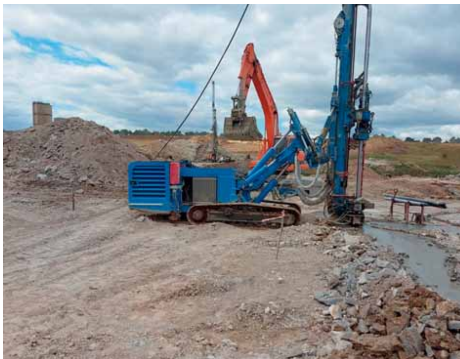
Рис. 1. Мероприятия инженерной защиты в условиях карстово-суффозионной опасности. Инъектирование скважин
