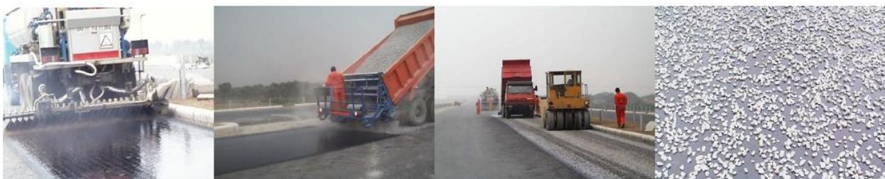
Рисунок 2.3.6 – Укладка битумно-минерального слоя при строительстве комбинированного дорожного покрытия (по материалам доклада RION [76] на Asia Highway Investment Forum (21.06.2021 [77]).
