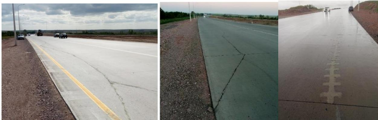
Рисунок 4.5.1 – Состояние цементобетонного покрытия дороги Темиртау – Караганда на третий год эксплуатации (строительство участка длиной 15 км начато в 2017 году, плановое завершение стройки – ноябрь 2018 год, по состоянию на 10.11.2021 дорога в эксплуатацию так и не принята) [10, 11].
