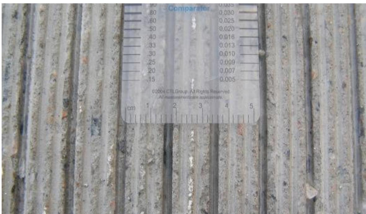
Рисунок 2.2.6 – Вид покрытия бетонной поверхности нового поколения (NGCS).
