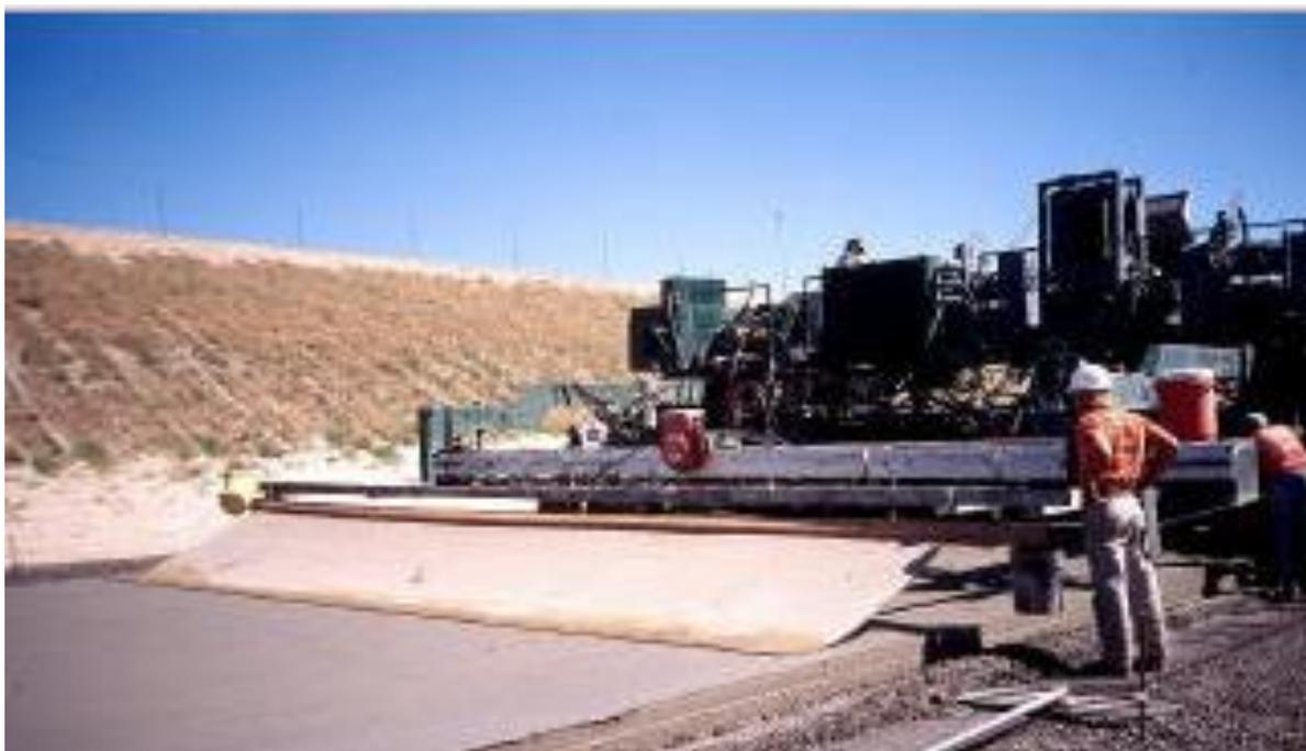
Рисунок 2.2.5 – Финишная обработка цементобетонного покрытия «Astroturf» (провинция Квебек, 1994 год).
