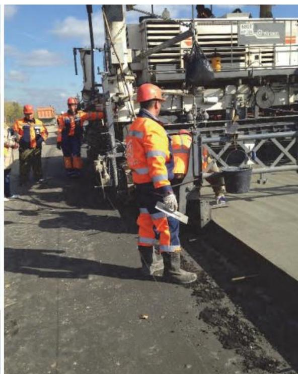
Рисунок 4.2.4 – Работы по устройству цементобетонного покрытия автомобильная дорога М-51, М-53, М-55 «Байкал».
