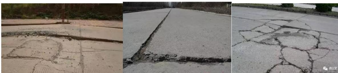
Рисунок 2.3.9 – Характерные дефекты дорожных покрытий из-за ошибок в оценке температурного поля грунта.
