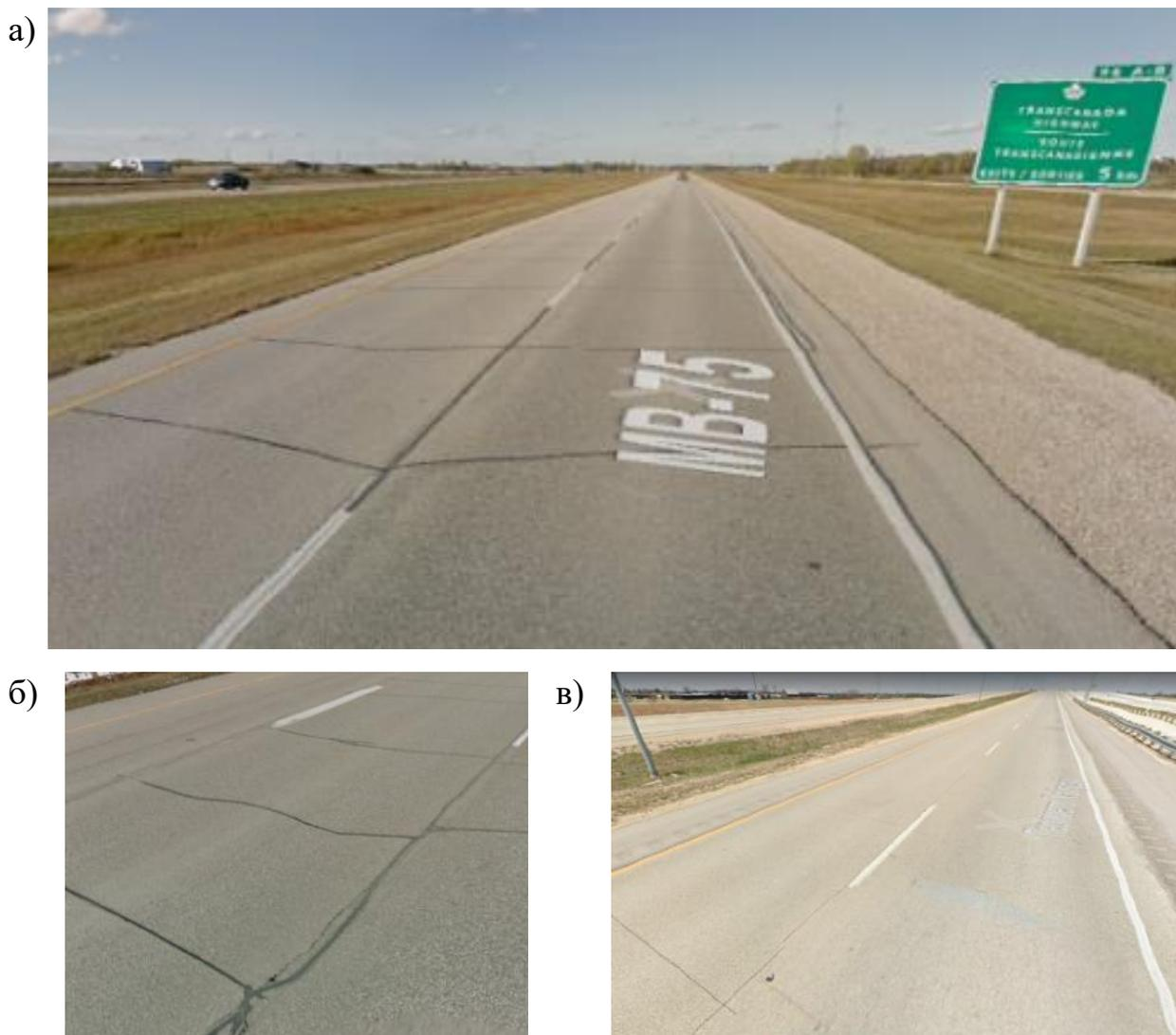
Рисунок 2.2.2 – Дорожное покрытие участков автодорог с жесткой дорожной одеждой в черте г. Виннипег:
