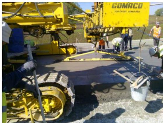
Рисунок 4.2.3 – Работы по устройству цементобетонного покрытия с применением укладчика Gomaso (автомобильная дорога Владивосток – Находка – порт Восточный)
